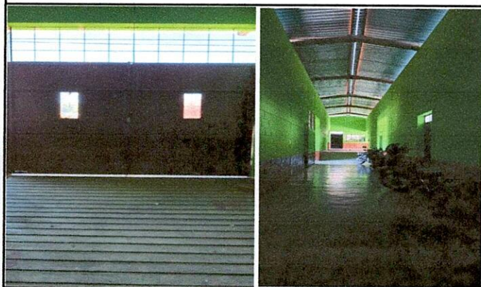
Foto 3: SUSTITUCIÓN DE PORTÓN PRINCIPAL E ILUMINACIÓN DE PASILLO
