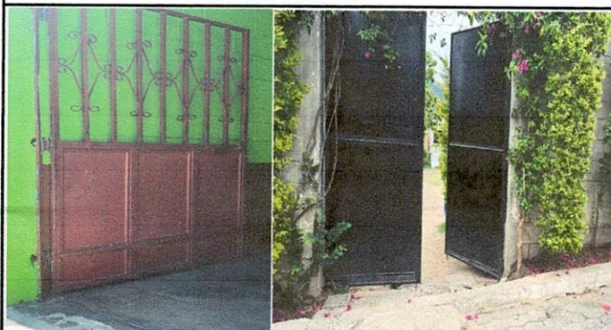
Foto 5: MEJORAMIENTO A PORTONES Y ENTRADA DE ABAJO
